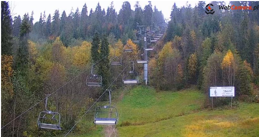
Ryc. 6. Przykład wpasowania kolei linowej w tereny leśne na stacji narciarskiej o wysokiej intensywności użytkowania (Kotelnica Białczańska)
